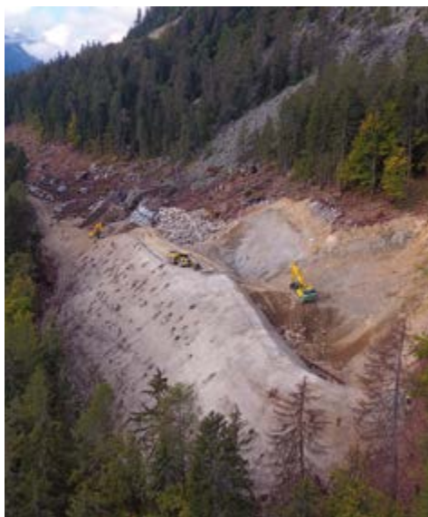
Les travaux ont débuté en mai dernier. Ils s'achèveront courant 2021.
